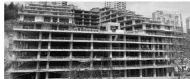
Şantiye fotoğrafı - podium bölümü Construction site photo - podium part
