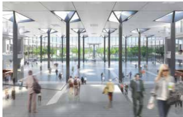
Özel tasarlanmış kolon başlıkları sayesinde binanın iç kısımları da doğal ışık alır. Thanks to the specially designed column heads, the interior of the building also gets natural light.
