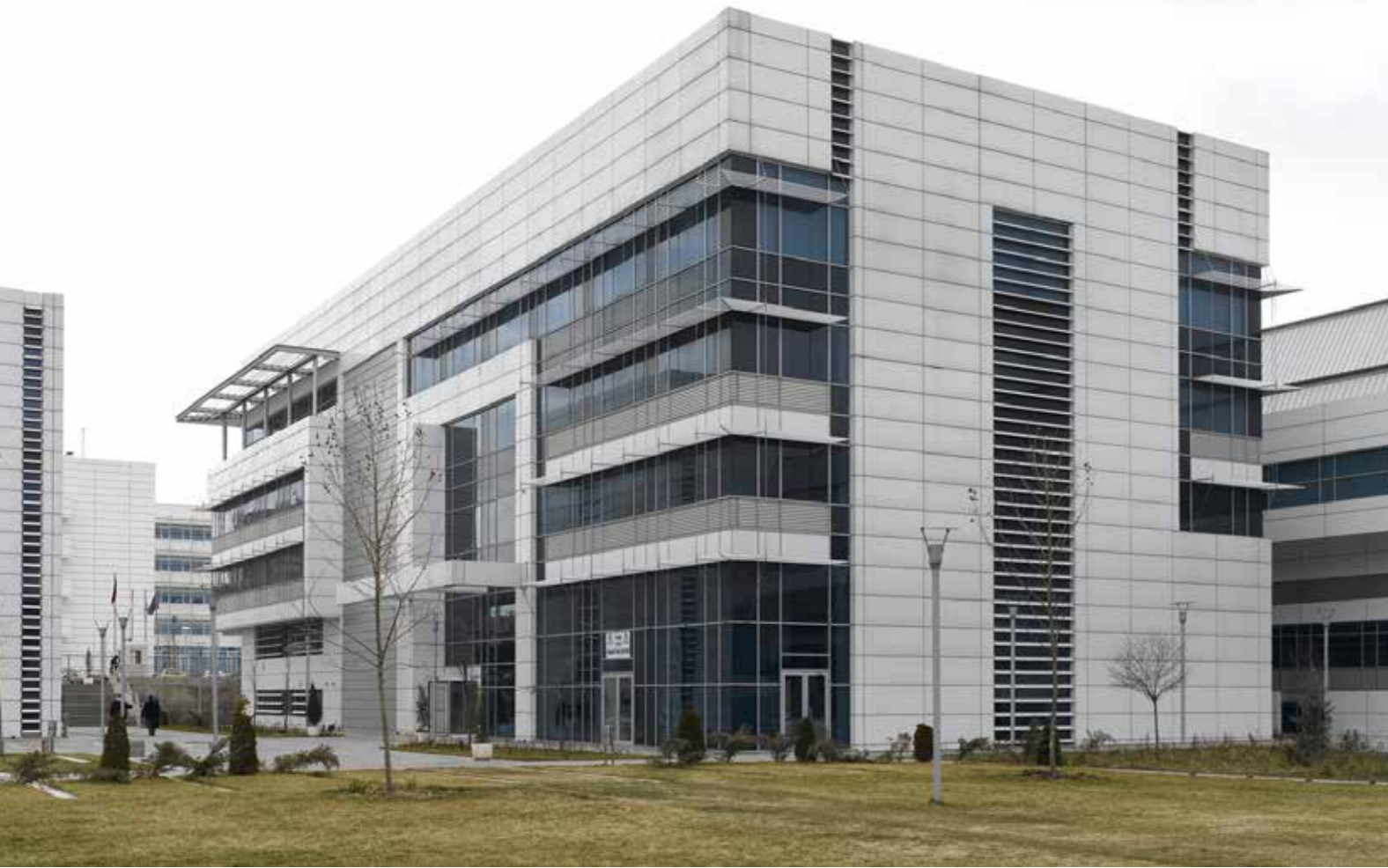
TEPAV binası renovasyon sonrası durumu TEPAV building after renovation
