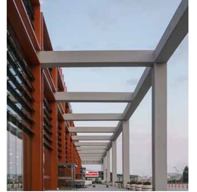
Cephe detay fotoğrafı Facade detail photograph
