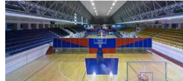
Spor salonu eski durumu (solda) ve renovasyon sonrası (sağda) Sports complex old condition (left) and after renovation (right)
