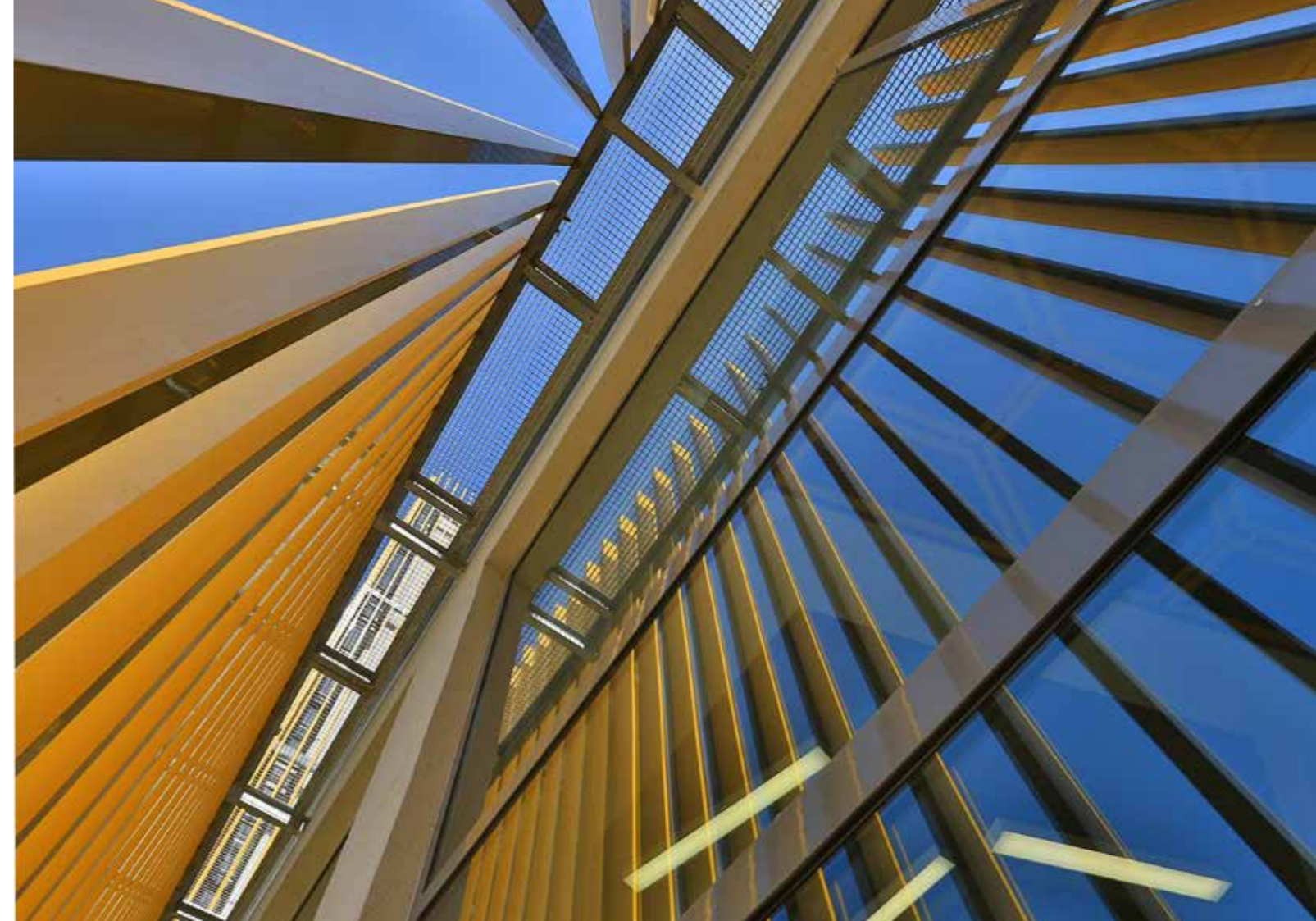
Sarı dikey güneş kırıcılar binanın genel karakterini oluşturur. Yellow vertical sunshades form the general character of the building.
